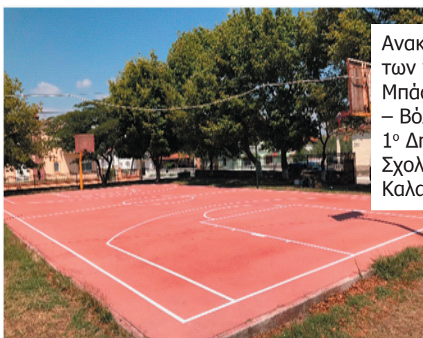
Κατασκευή γηπέδου Μπάσκετ- βόλεϊ
