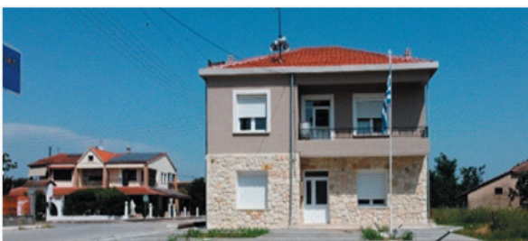
Ανακατασκευή Κτηρίου Κοινότητας Νεροφράκτη
