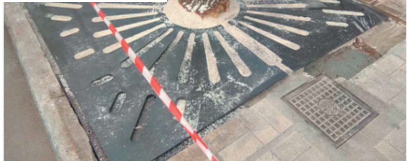
Τοποθετήσαμε σχάρες για την προστασία των πεζών
